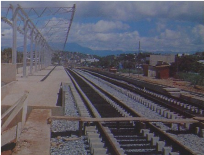
Em 1978 foram implantados os primeiros trechos de via permanente do Pré-Metrô
